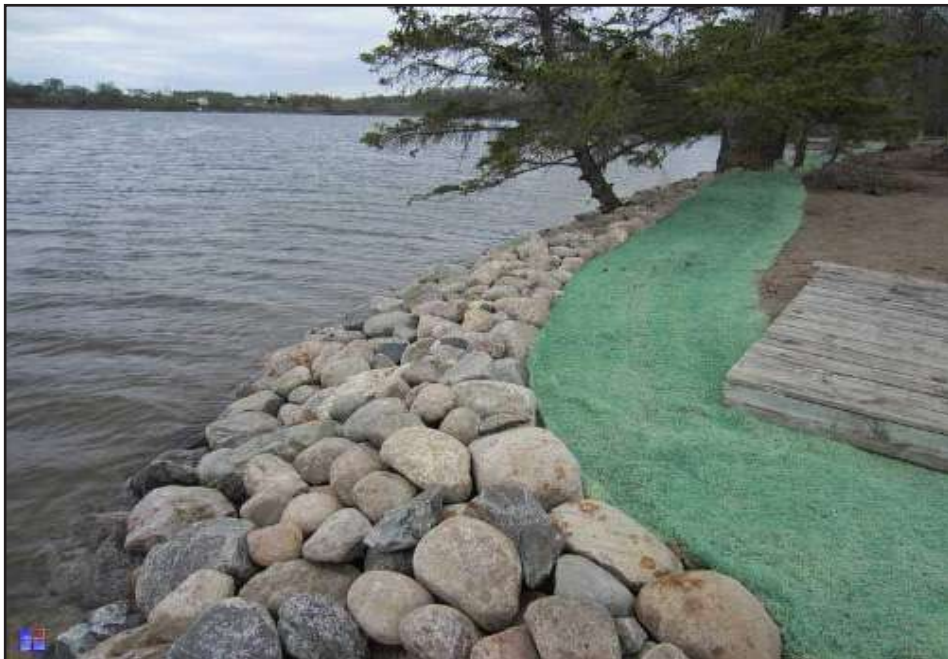
شکل ۳-۶- عملیات سنگ لاشه
