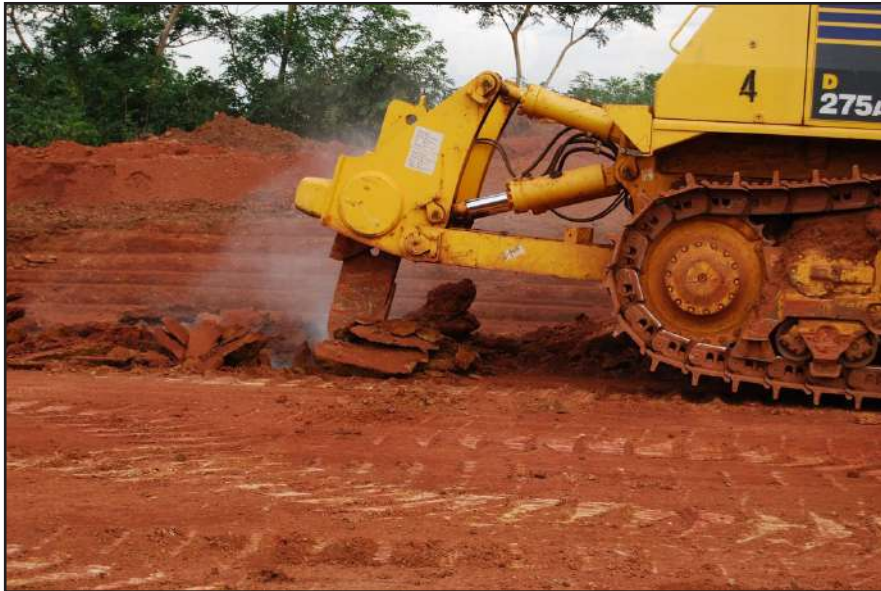
شکل ۴-۴- عملیات ریپرزدن
